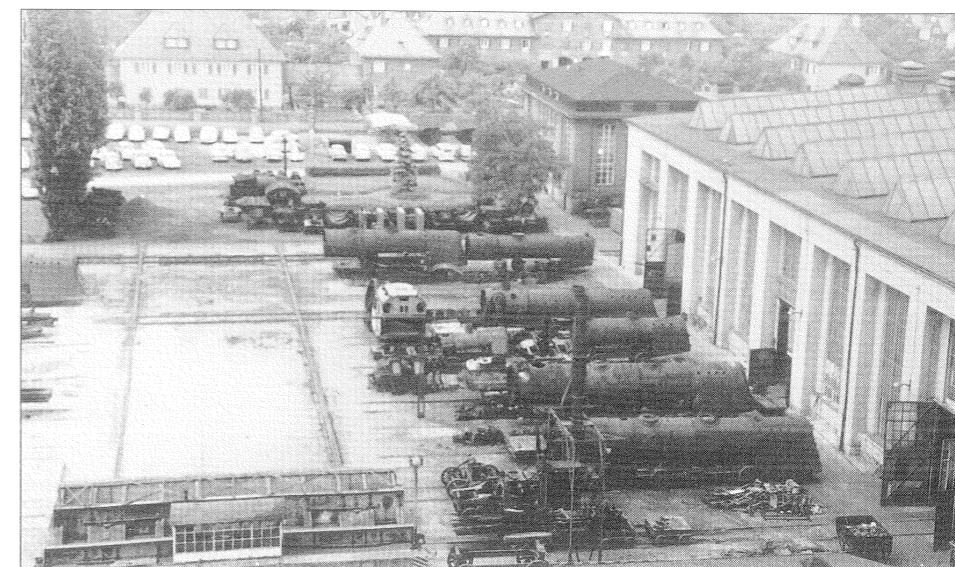
Blick vom Kesselhausturm auf Schiebebühne und Lokomotivkessel, Sommer 1964
